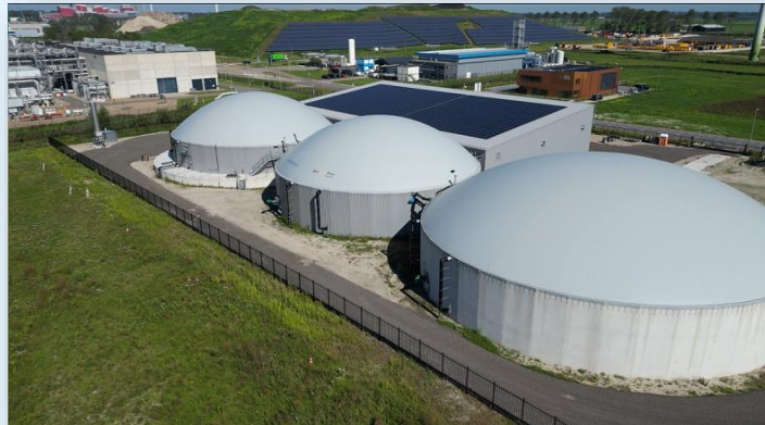
RGE Alkmaar (Sustenso) 47GWh
